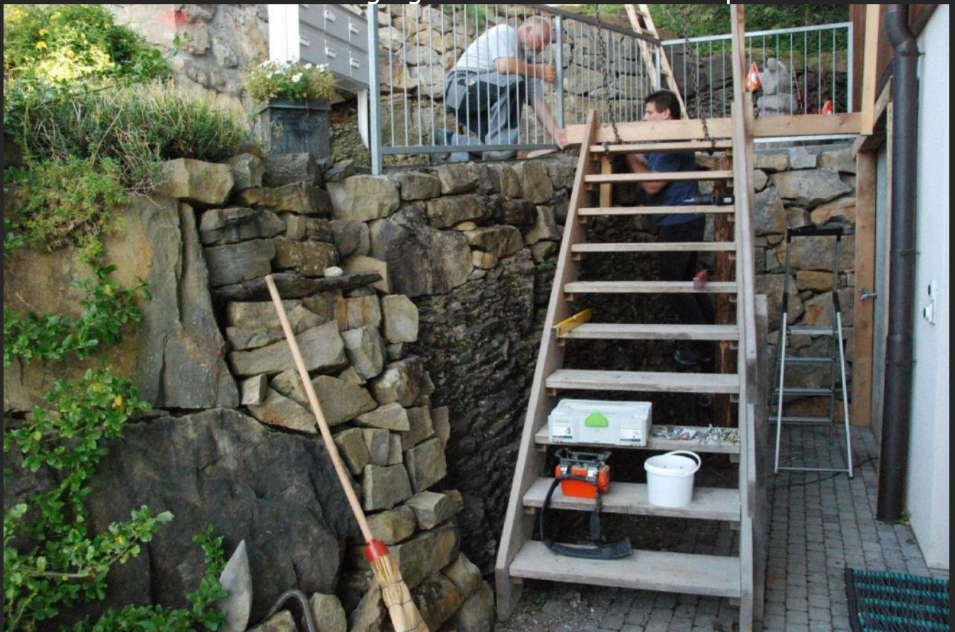
Provisorischer Zugang für die Zeit der Rohbauphase.
