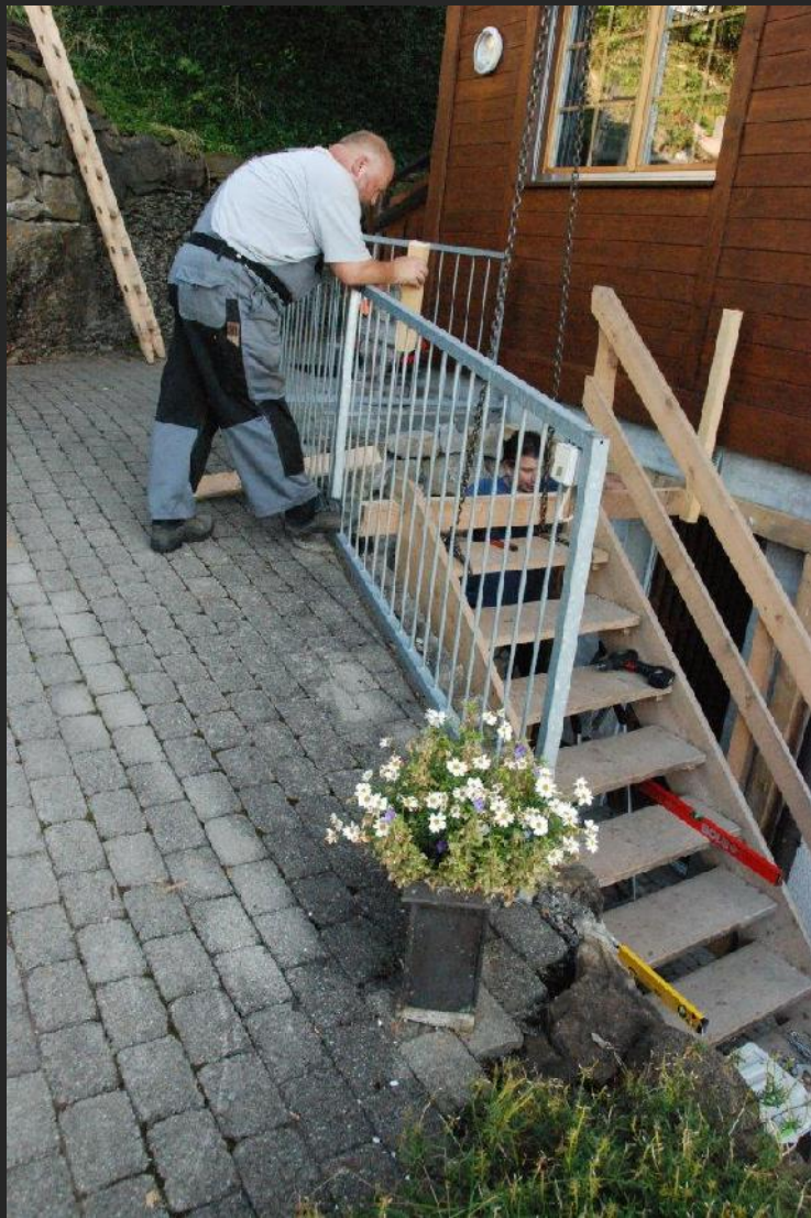
Provisorischer Zugang für die Zeit der Rohbauphase.
